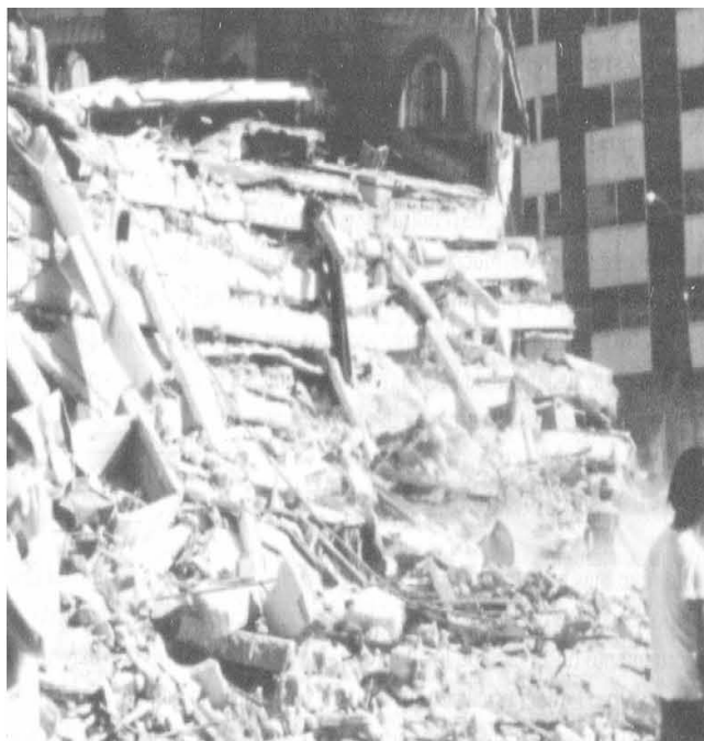
Figura 2.35. Colapso de un edificio por falla de columna (Bazán y Meli, 1999).
