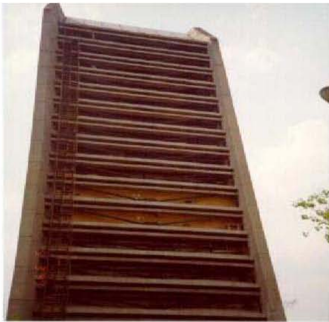
Figura 4.3. Reforzamiento estructural (Vista Frontal)
