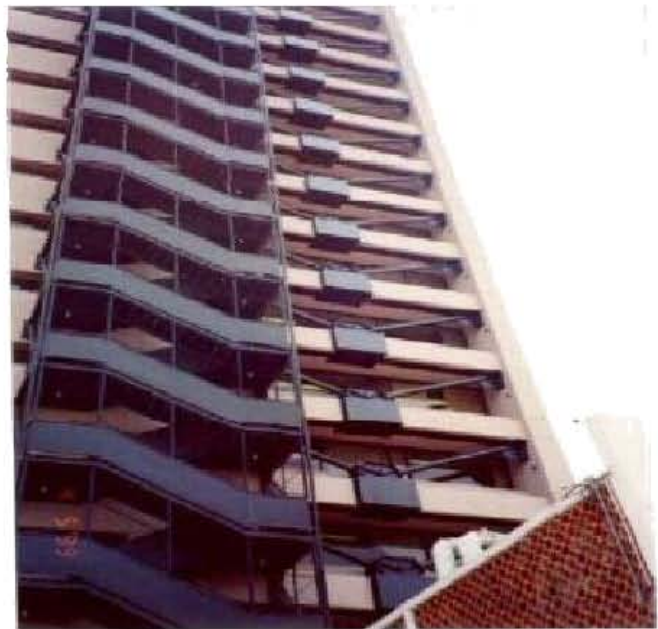
Figura 4.4. Reforzamiento estructural (Vista Posterior)
