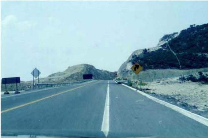
FOTO No. 8. Km 19+800 vista hacia Tehuacan. Zona de cortes. Taludes protegidos con concreto lanzado. Disposición inadecuada de material residual de los cortes en la ladera aguas abajo asimismo se observa ausencia casi total de vegetación en la misma zona
