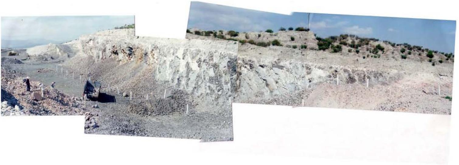
FOTO No.4. Banco de material Km 3+000 50m. D.D. vista hacia Tehuacan, el cual seguirá en funcionamiento como parte de las instalaciones de apoyo de la autopista así como la planta trituradora ubicada en el km 3+500 al interior del mismo banco. En la parte superior del corte se observa parte del suelo despalmado y donde ha crecido vegetación de manera espontánea.
