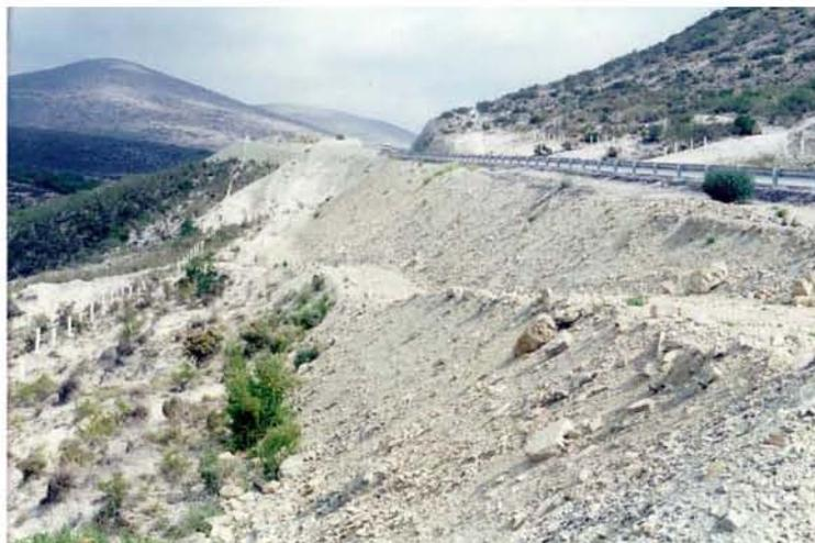
FOTO No. 5. Km 17+000 D.D. Vista del terraplén. Material susceptible a deslizarse hacia la parte baja del valle intermontano ocasionando el daño a la vegetación de las laderas del mismo así como al escurrimiento superficial que se desarrolla al fondo del mencionado valle.
