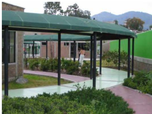
Vista cruce de circulaciones y cafetería al fondo. Los macizos vegetales añaden color y textura a los espacios
