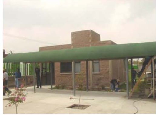
Vista desde plaza de acceso de andador techado y edif. administrativo en construcción
