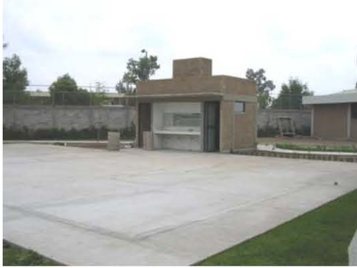
Cancha de cachibol y módulo de vestidores en construcción
