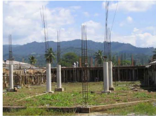
Foto 14. Vista del patio central y visual abierta hacia el paisaje natural
