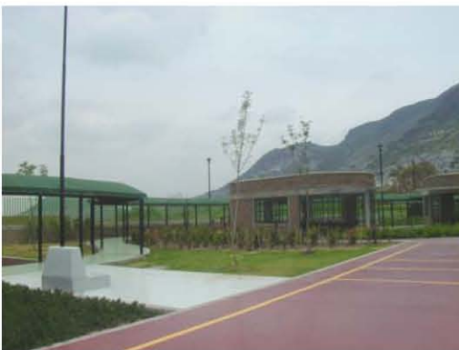
Vista desde la cancha hacia zona de aulas. La visual abierta al sureste da una idea de mayor amplitud
