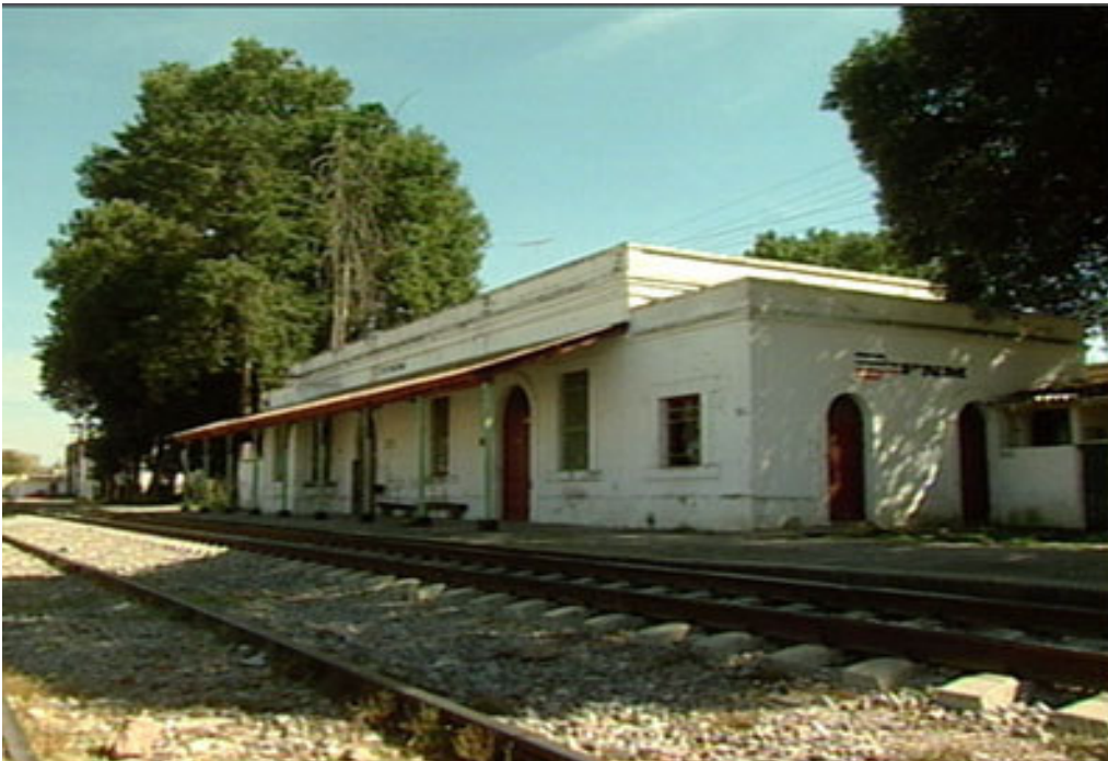
Figura No. 3. Vista de una estación de tren en una hacienda pulquera, la cercanía de la línea de ferrocarril es para facilitar su comercialización a distancia.
