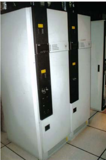
Fig. II.2.4.- Aspecto externo de un Amplificador de Potencia
