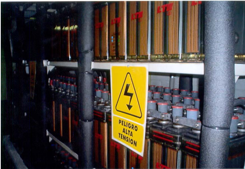
Figura II.1.15.- Conexión de un banco de baterías.
