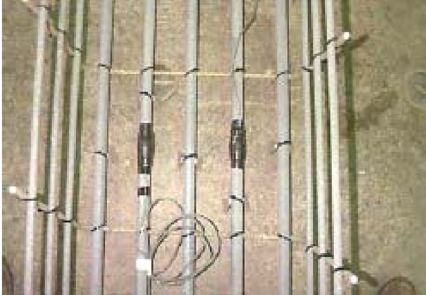
Figura 19: Armado tipo para una columna (Universidad de Toronto Canadá) Por Dr. En Ing Aftab Mufti
