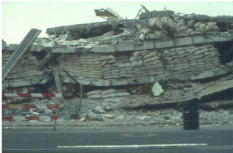
Figura 2: Edificio con cambio de uso de suelo diseñado para uso habitacional y convertido en almacén de granos.
