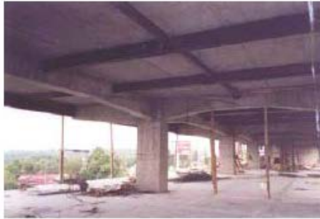
Fig. 36 Edificio con grandes volados entre columna y columna (Imagen obtenida del XVI Congreso Nacional de Ingeniería Estructural) M.I Enrique del Valle Calderón
