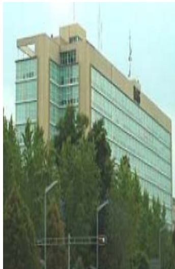
Fig. 35. Edificio con varios pisos de altura, Av Paseo de la Reforma (Imagen obtenida del XVI Congreso Nacional de Ingeniería Estructural) M.I Enrique del Valle Calderón
