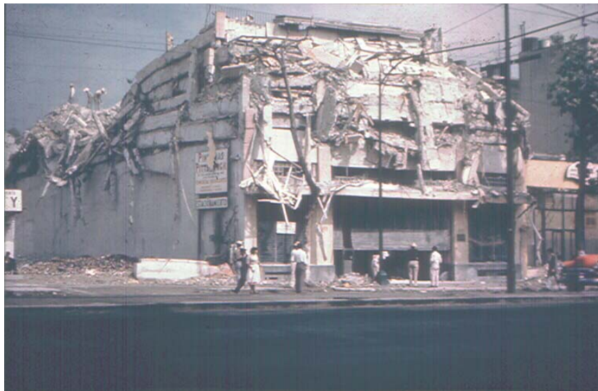
Figura 6: Colapso por torsiones de trabes y columnas en los pisos superiores de un edificio (16)
