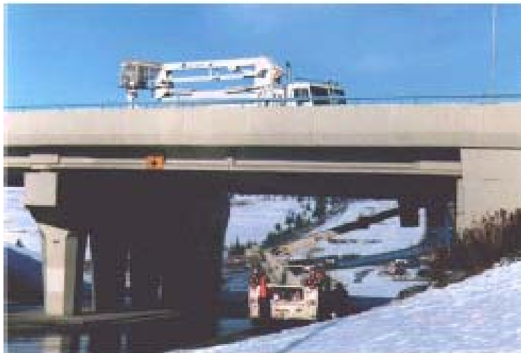
Figura 1: Puente "The Beddington Trail" de Concreto con Fibra de vidrio polisensorial en Toronto Canadá por A.A Mufti
