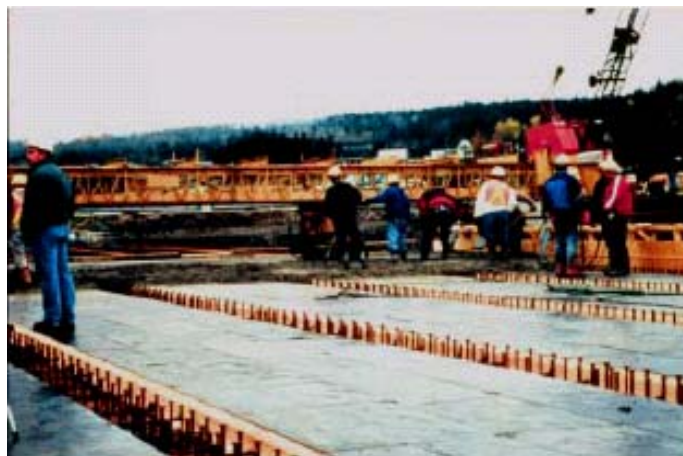
Fig. 15: Puente Vehicular en Toronto Canadá con Fibra de Vidrio sensorial por A. A. Mufti
