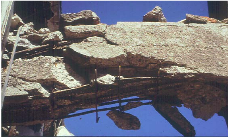
Figura 7: Giro en el nodo izquierdo de una estructura entre la columna y la trabe (17)
