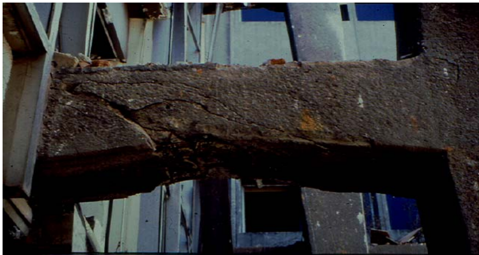
Figura 3: Falla por esfuerzo cortante, con grietas de 30 a 45° (Imagen tomada de la ponencia “Experiencias adquiridas en el Diseño de Estructuras en Zona Sísmica” por M.I Enrique del Valle Calderón e Ing. Francisco García Jarque, XIV Congreso Nacional de Ingeniería Estructural 2004)
