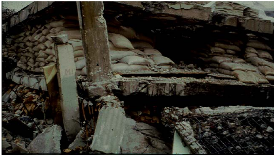
Figura 5: Ejemplo de Desplazamiento Horizontal por sismo (14)
