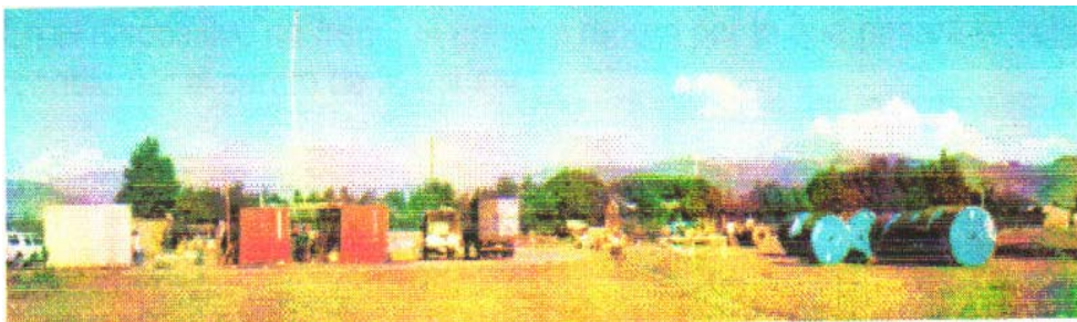
Figura 5-3.- Campamento- Almacén de OPGW.
