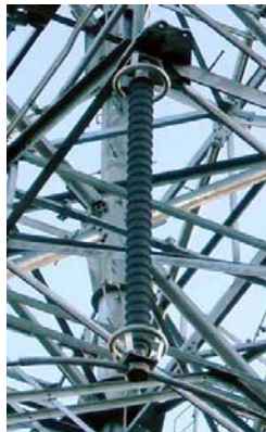
Figura 3-4.- Aislador de suspensión de material polimérico.
