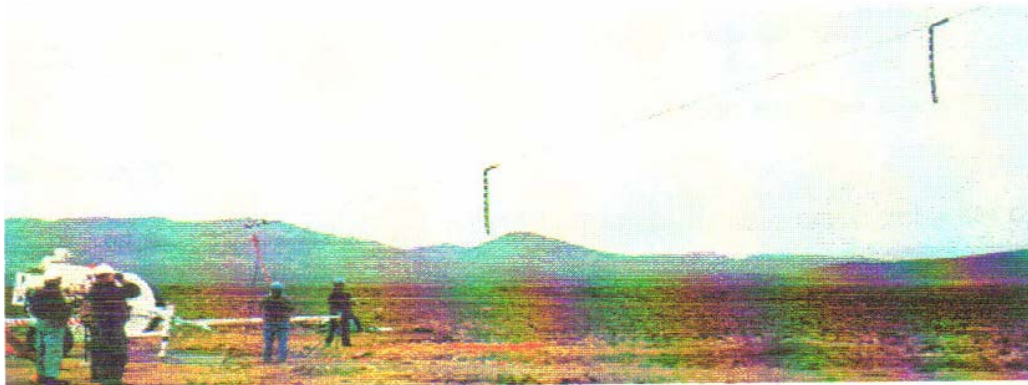
Figura 5-5.- Salida de la punta de tiro de la frenadora.
