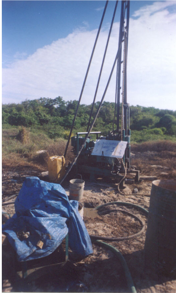
FOTO19. En la zona donde se efectuó el Sondeo SPT-3, la capa vegetal ya se presenta con un espesor aproximado de 10cm.
