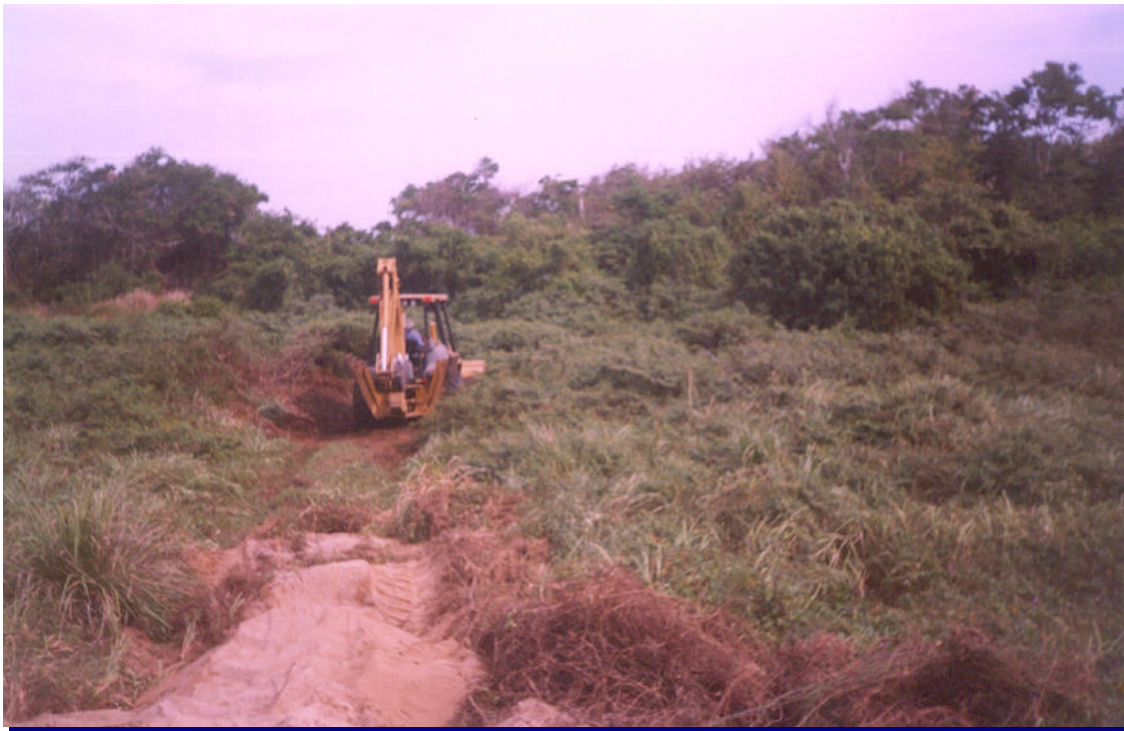
FOTO 04. En esta vacación se muestra el movimiento de la maquinaria para la perforación superficial a los sitios indicados por parte de la empresa NOLTE de México S.A. de C.V.
