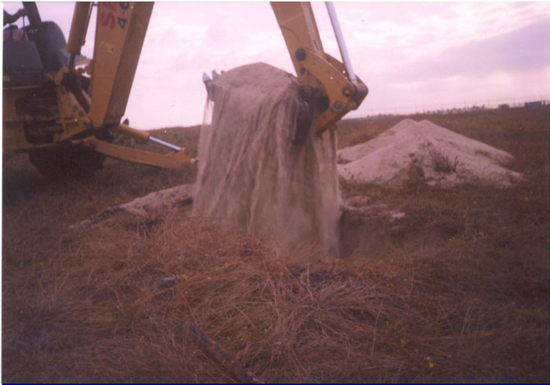
FOTO 05. Se observan los trabajos de excavación por medio de retroexcavadora, realizada en los Pozos a Cielo Abierto, correspondientes a la exploración superficial.
