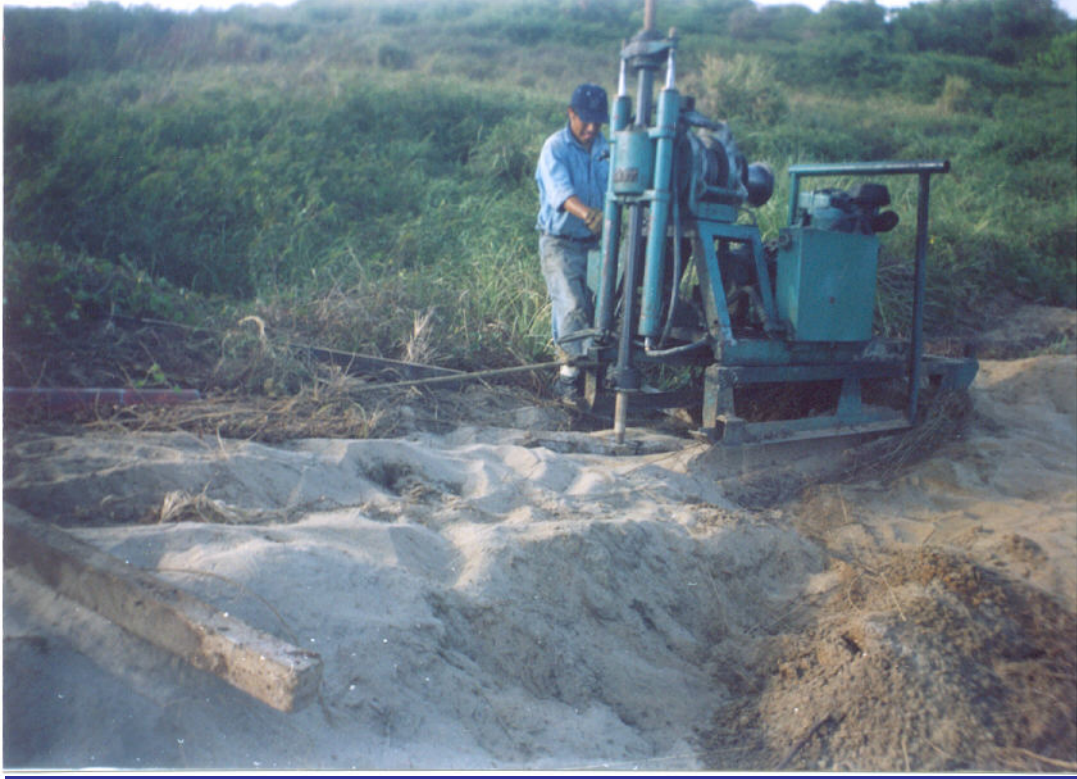
FOTO14. Se tiene el relleno de arena, el cual llegó hasta una profundidad de 1.10m, el cual se encuentra en la zona donde se realizó el Sondeo Mixto SM-01.
