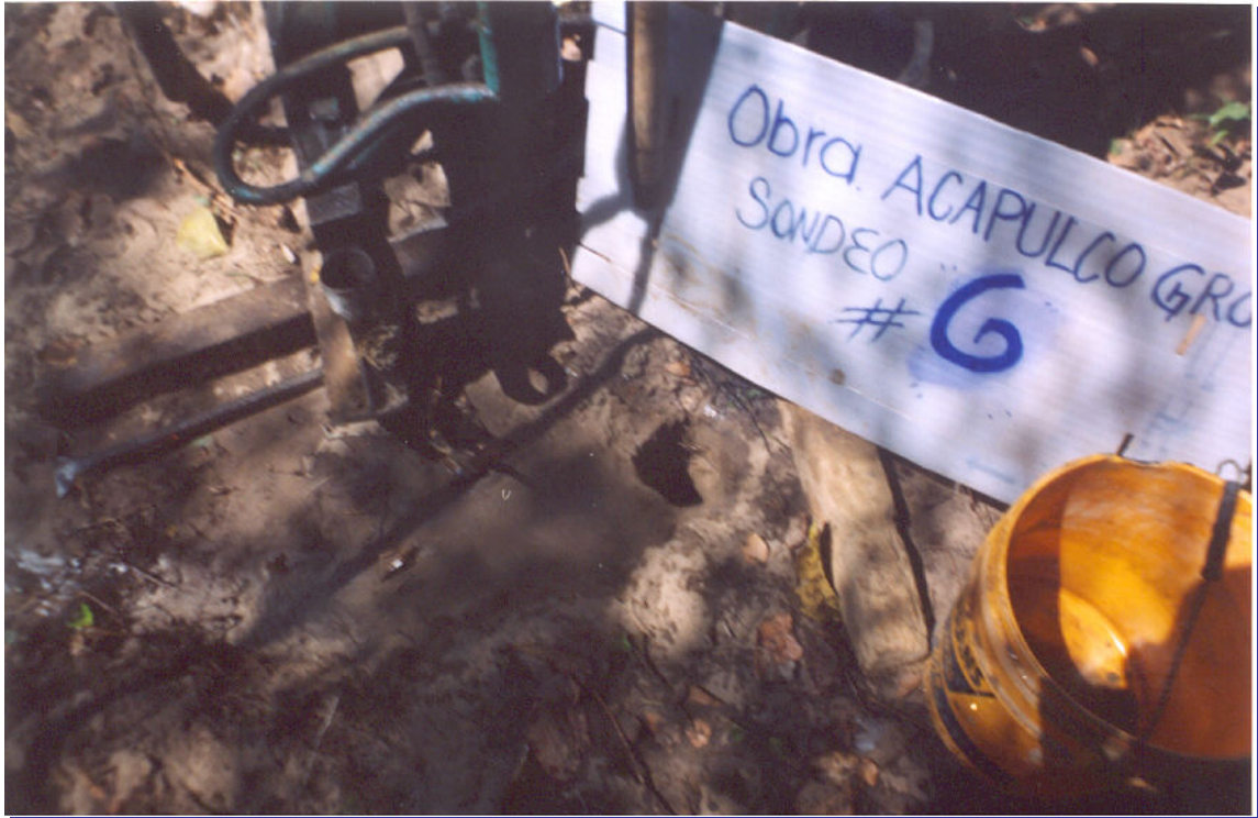
FOTO26. En el Sondeo SPT-6 se detectó que la capa vegetal alcanza un espesor máximo de 30cm aproximadamente, como también lo corroboran los Pozos a Cielo Abierto cercanos a esta zona..
