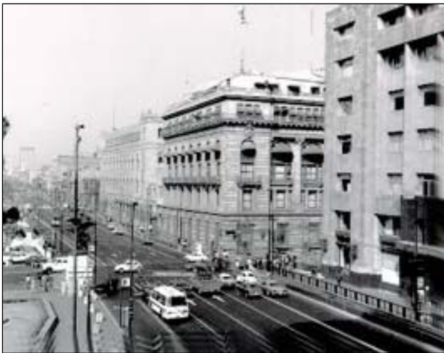
Fig. 2.2.6: Aspecto actual del edificio. Colegio de San Juan de Letrán. México, 1548.
