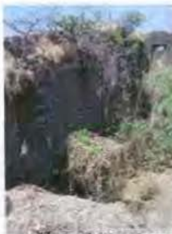
Área cubierta anteriormente con bóveda de cañón con arco de medio punto de mampostería.
