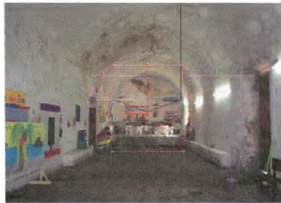
Vista interior de la crujía oriente, donde aun se conservan la cubierta de bóveda de cañón corrido de medio punto deprimido 187
