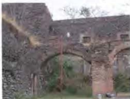
Vista crujía norte
