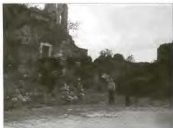
Vista esquina sur oeste del claustro del hospital.
