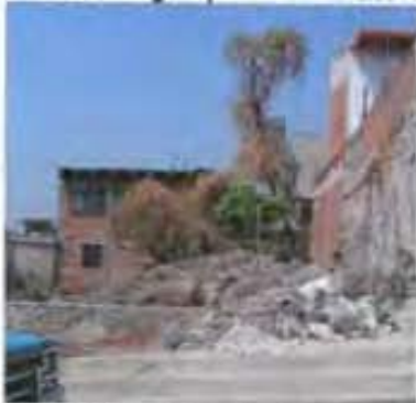
Imagen del mismo predio con construcción vernácula demolida. Marzo 2005
