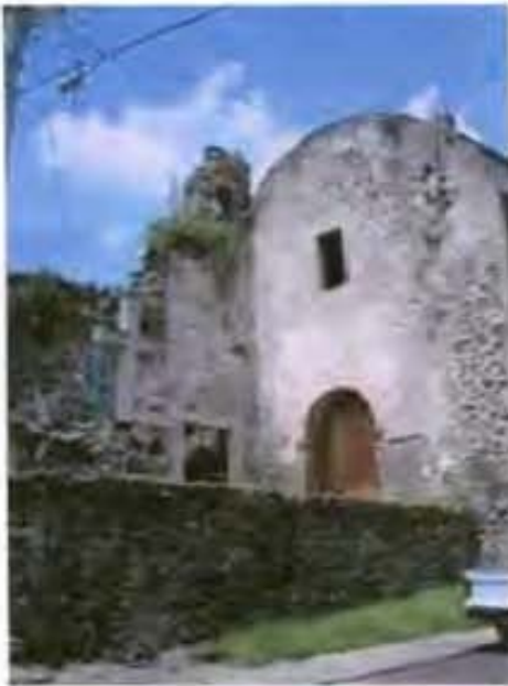
Vista de la Capilla del Hospital 174
