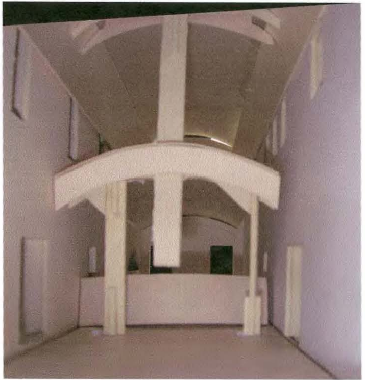
Apoyos recibiendo cilíndricas largas de entrepiso y azotea
