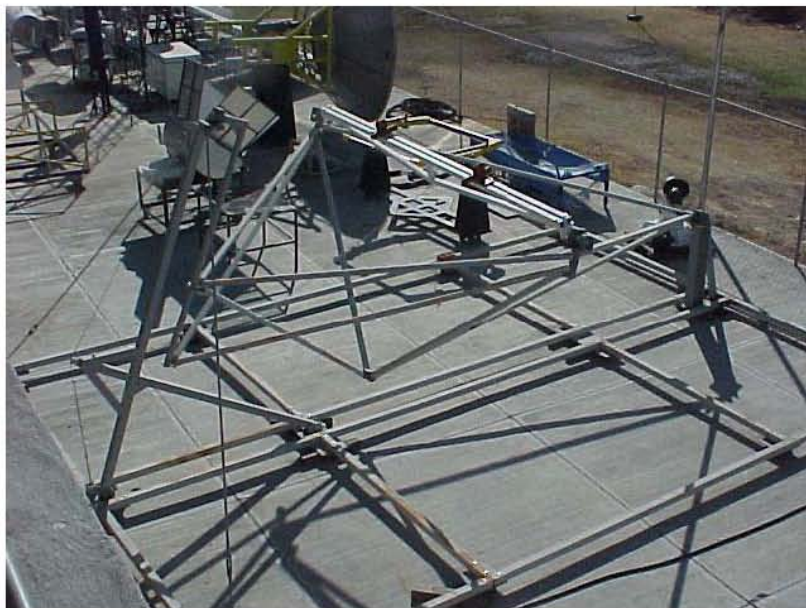
Figura 2.33: Vista superior de la estructura.
