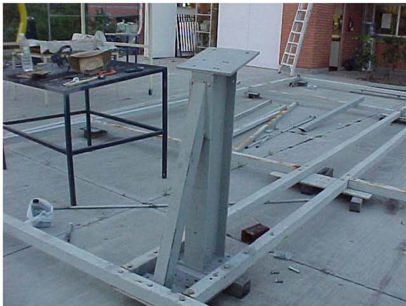
Figura 2.27: Colocación del soporte del nodo A.
