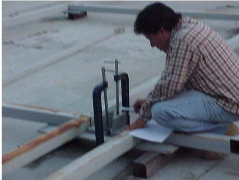
Figura 2.26: Colocación de placas.
