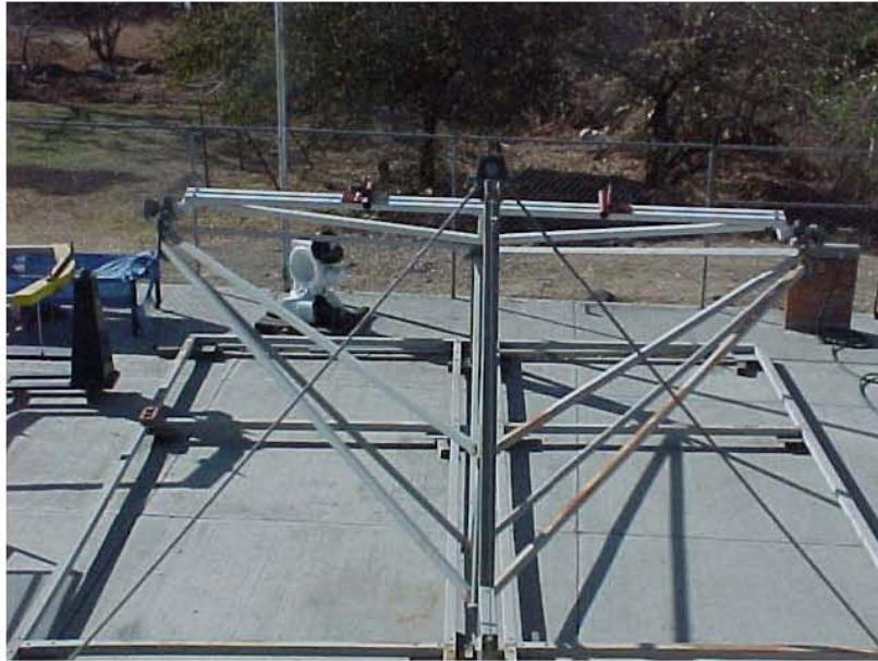
Figura 2.32: Vista frontal de la estructura.
