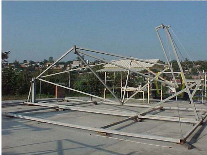
Figura 2.30: Nodos ensamblados.
