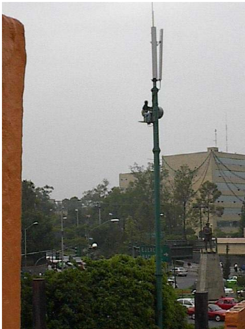
Torre tipo Monopolo para RF y MW
