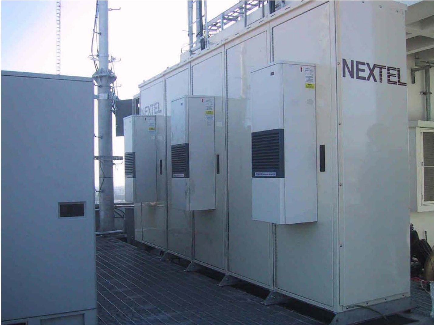
Gabinete instalado en sitio y anclado a rejilla Irving mediante espárrago de acero galvanizado de 3/8" con tuerca y contra-tuerca.
