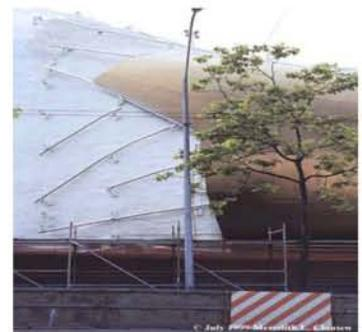
8 Recubrimiento de placas de acero
