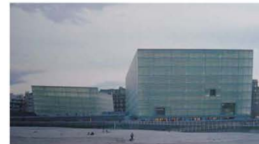
FIG. 12 Vista de los dos volúmenes inclinados.
