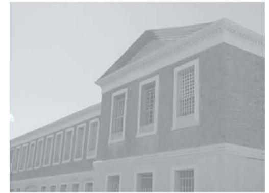
FIG. 1 Vista exterior de la Antigua Prisión de Belice, construida en 1857.
