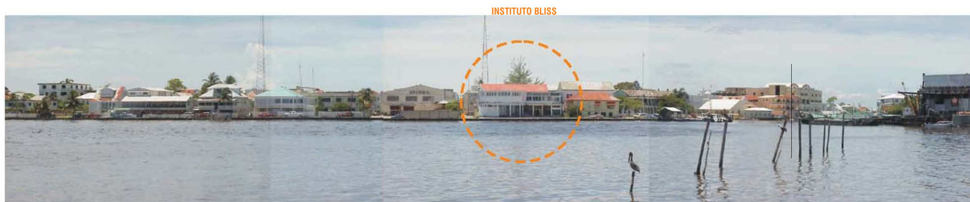
FIG. 5 Vista panorámica frontal.
