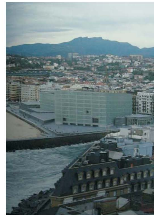
FIG. 10 Vista del Auditorio del Kursaal en la desembocadura del Río Urumea.
