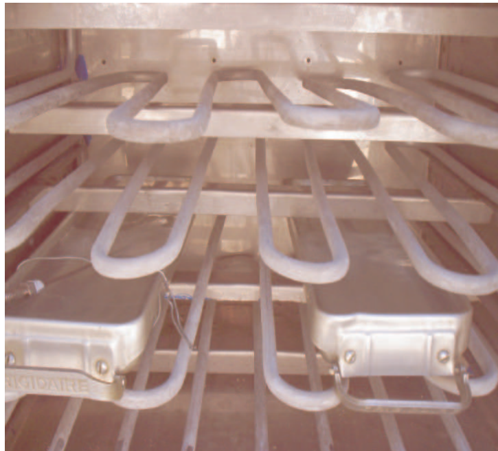
Fig. 6.42 Detalle de las charolas con hielo en el interior de la cámara frigorífica
