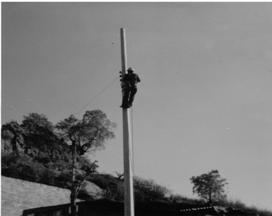
Instalación de los postes de energía eléctrica (1991). Fotografía proporcionada por: Alejandro Ramos, residente de la Colonia Buenavista.
