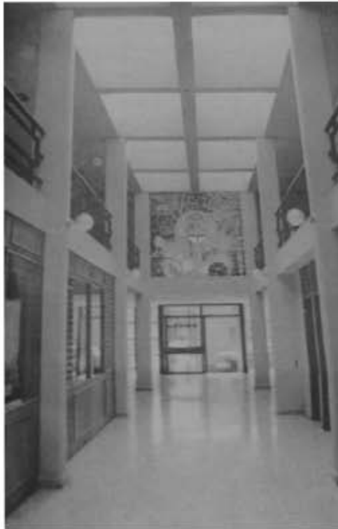
REMODELACIÓN DEL EDIFICIO DE GUADALUPE
