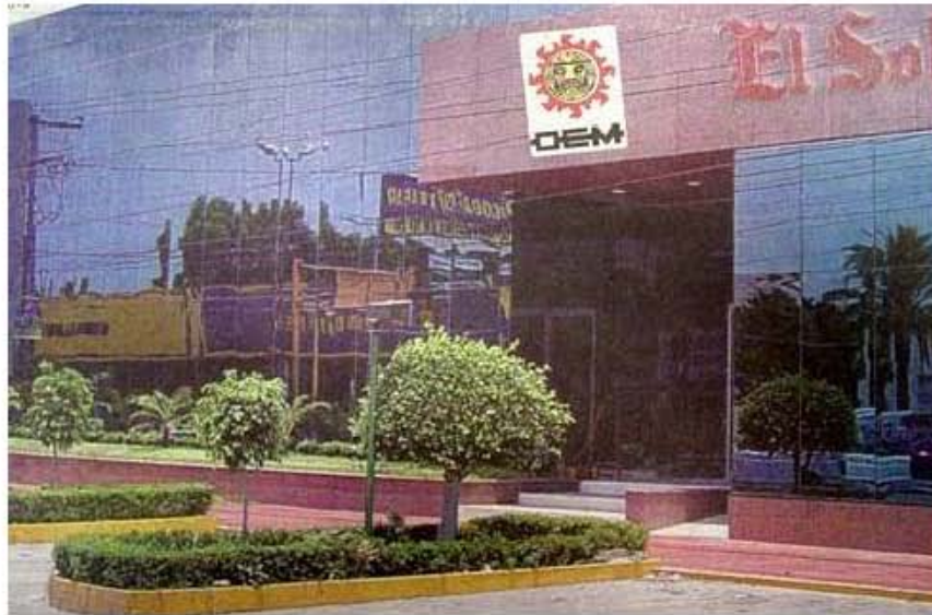
NUEVAS INSTALACIONES DE EL SOL DEL BAJIO
