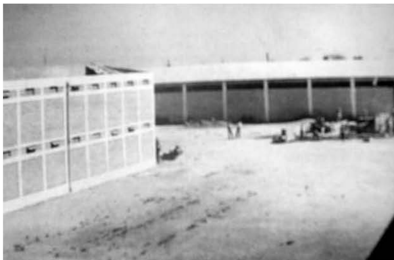
CONSTRUCCIÓN DEL CENTRO DE READAPTACION SOCIAL EN CELAYA
