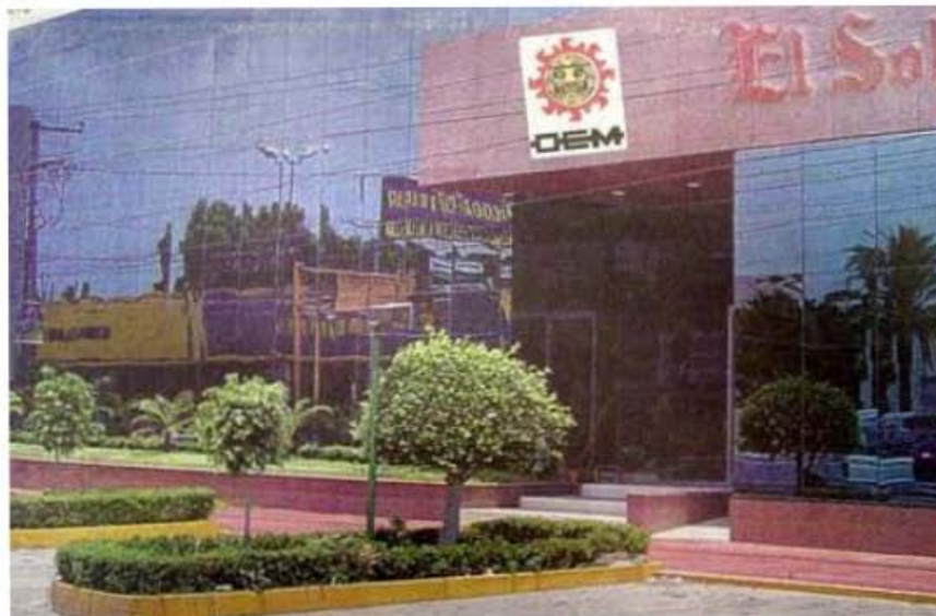
NUEVAS INSTALACIONES DE EL SOL DEL BAJIO
