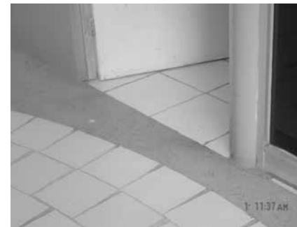
Foto. 4. El acabado de los pisos es antiderrapante y como se observa en la fotografía cambia con el uso del local, de una loseta lisa en el interior a un espacio de concreto y posterior a este una loseta
