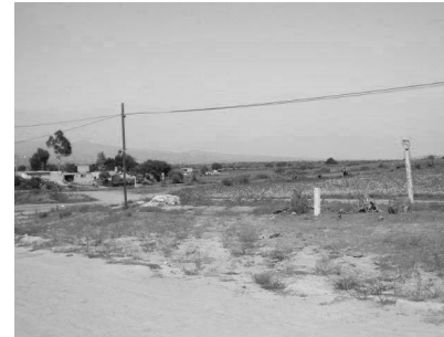
Foto 19. Pozo de visita en vialidad de terracería
