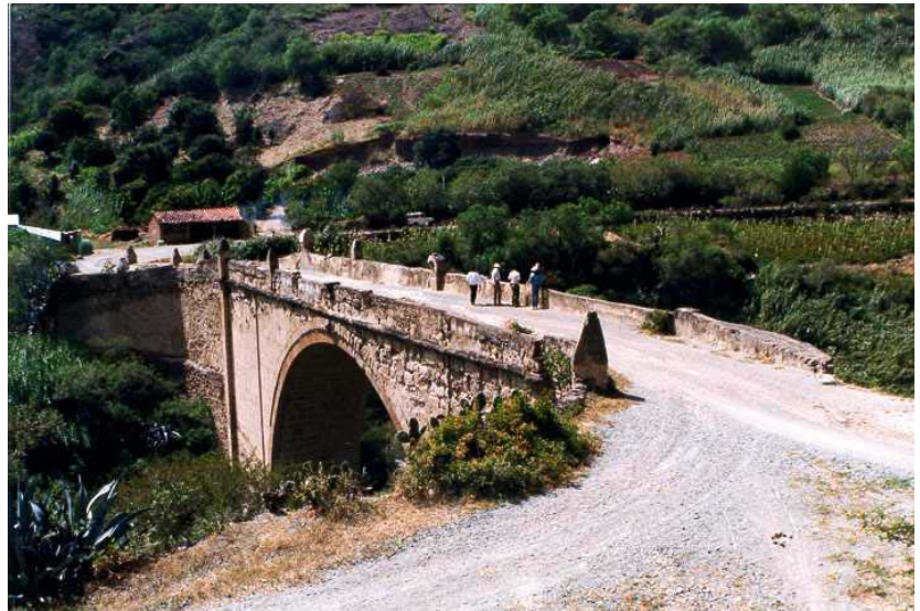
1.35 Puente sobre el río Pachachaca ↴
