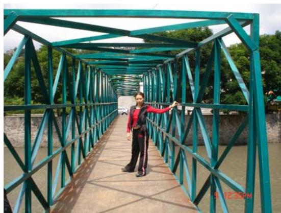
1 < El puente peatonal del Río Zapoapan esta hecho a base de una estructura de acero y losacero, además, esta ubicado al nororiente de la zona.
