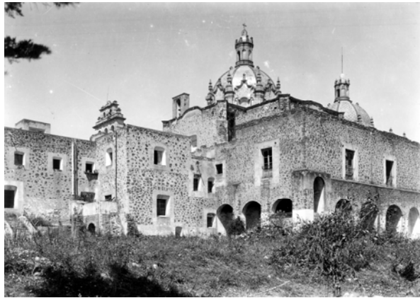
1925. Exterior del Convento del Carmen. Foto: Manuel Ramos/ Fototeca CNMH
