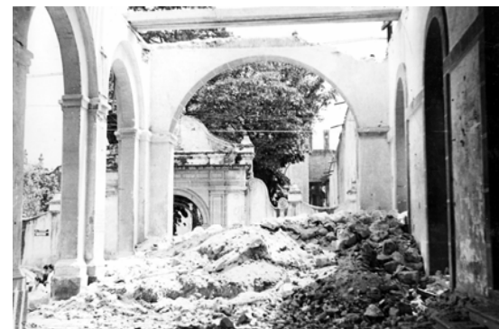
1952. Demolición del antiguo Palacio Municipal, para prolongar la avenida Revolución hasta C.U./ CNMH
