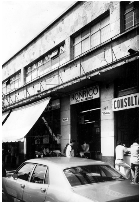
1970. Av. Revolución. Los edificios se han adaptado a la dinámica urbana/ CNMH
