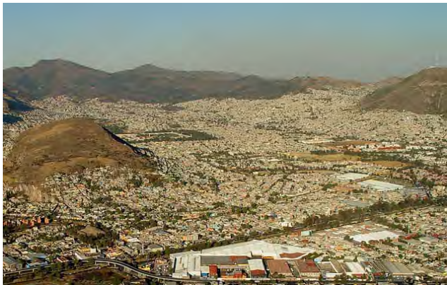
Zonas habitacionales de Cuautepec. Los equipamientos se encuentran lejos de ahí/ Foto: Óscar Ruiz
