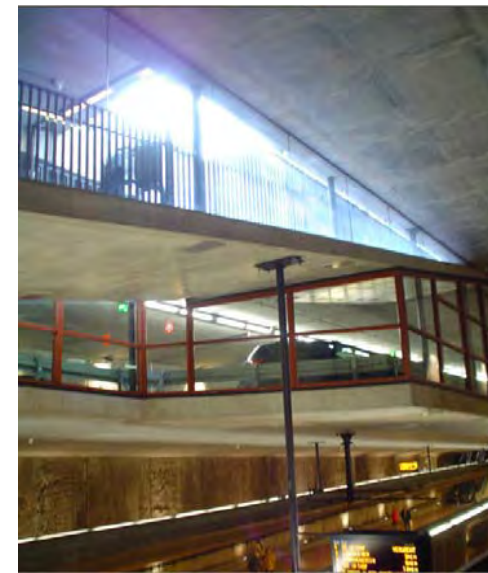
Estacionamiento Público subterráneo y acceso peatonal/ Foto: Juan Alonso
