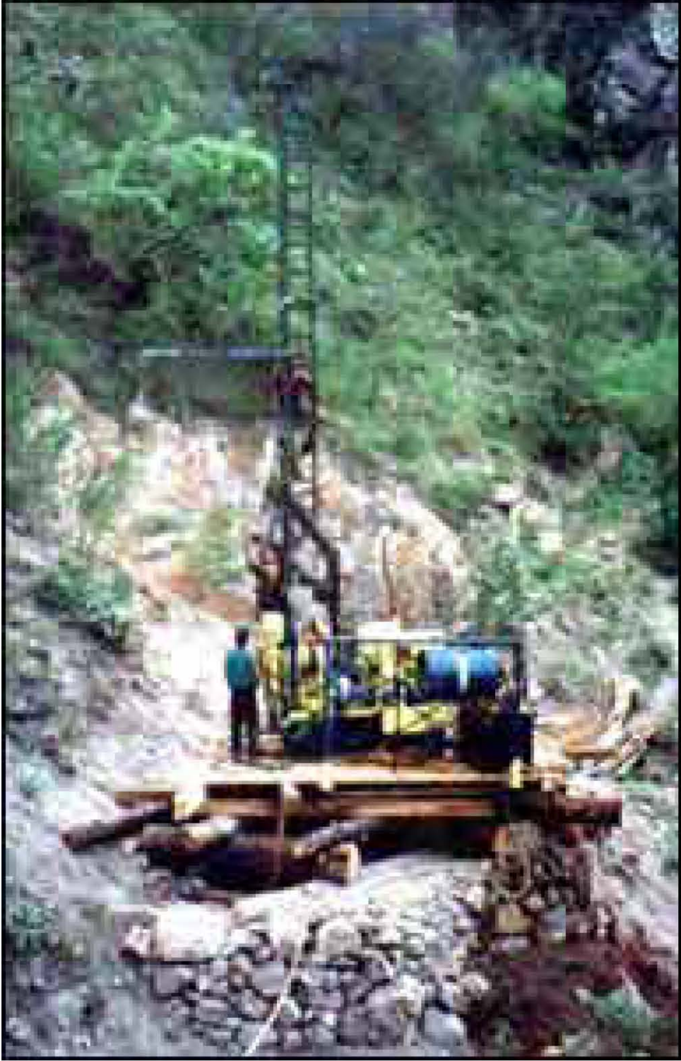
Cuadrilla de trabajadores operando una máquina Long Year 44
