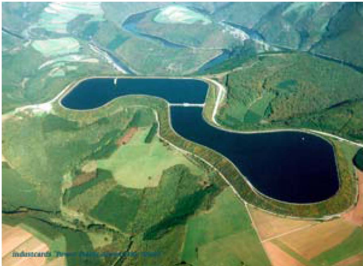
Vista aérea del vaso superior de la planta de bombeo localizada cerca del poblado de Vianden, en Luxemburgo.
