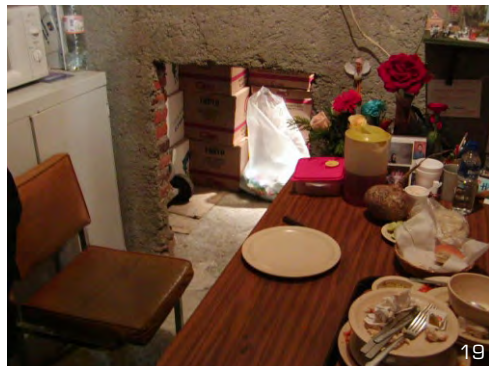
IMAGEN 19 / COMEDOR DE LOS EMPLEADOS CON ÁREAS SUMAMENTE REDUCIDAS E INSUFICIENTES PARA TODO EL PERSONAL
