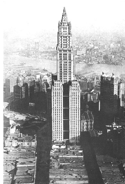
FOTO DEL EDIFICIO WOOLWORTH , CON SUS 241,50 METROS SOBRE EL PAVIMENTO Y UNA ALTURA TOTAL DESDE LOS CIMIENTOS DE 276 METROS , CON 60 PISOS , CON UN SERVICIO DE ASCENSORES DIRECTOS , EN CUYA CONSTRUCCIÓN SE EMPLEARON 30.000 TONELADAS DE ACERO ERA EL EDIFICIO MAS ALTO DEL MUNDO EN ESOS TIEMPOS.
