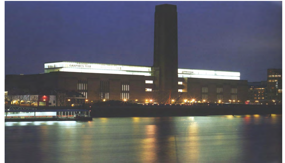
IMAGEN 01 / VISTA DEL MUSEO TATE DONDE SE APRECIA LA ESTRUCTURA DE VIDRIO DE DOS PISOS QUE CORRESPONDE AL ÁREA DEL CAFÉ
