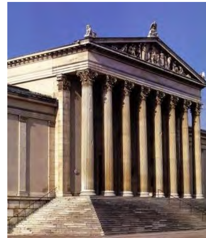
LA PLAZA REAL ABIERTA EN EL MUNICH ROMÁNTICO SE INICIÓ CON LA CONSTRUCCIÓN DE LA GLIPTOTECA. KLENZE SE INSPIRÓ EN LAS TIPOLOGÍAS DE GALERÍAS DE EXPOSICIÓN DE DURAND PARA REALIZAR ESTE EDIFICIO DOMINADO EN SU EXTERIOR POR UN PÓRTICO DE TEMPLO DE ORDEN JÓNICO Y POR UN ASPECTO COMPACTO, PROPIO DE LA SEVERIDAD NEOGRIEGA. LA GLIPTOTECA HABÍA DE SERVIR DE MARCO PARA UNA EXTRAORDINARIA COLECCIÓN DE ESCULTURA ANTIGUA QUE FUE INSTALADA POR THORVALDSEN. EL MUSEO DISTRIBUYE SUS SALAS ABOVEDADAS EN TORNO A UN PATIO CUADRADO. SE CUIDÓ MUCHO LA DECORACIÓN DE LAS BÓVEDAS Y EL EMBELLECIMIENTO DE LOS MUROS, PERO ESTOS ELEMENTOS NO SE RECONSTRUYERON DESPUÉS DE LOS ENORMES DESTROZOS DE LA II GUERRA MUNDIAL EN EL EDIFICIO
