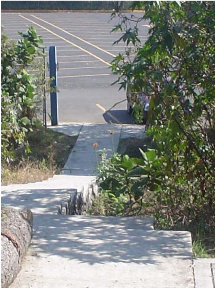
Conexión del estacionamiento 3 al estacionamiento 4 que es parte del terreno.
