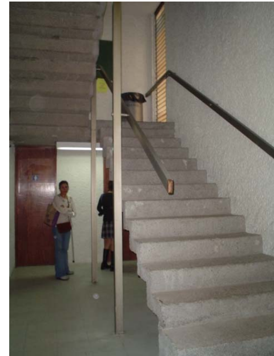
Escalera y en el fondo se encuentran los sanitarios.
