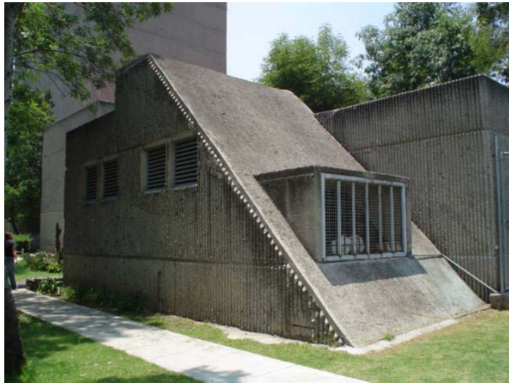
Planta de energía eléctrica.
