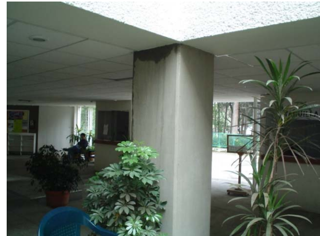
Detalle de la estructura a base de columnas y losa nervada con plafón.
