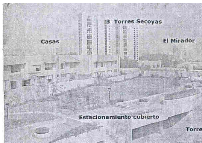
Fotografía No. 5. Vista panorámica del condominio I.
