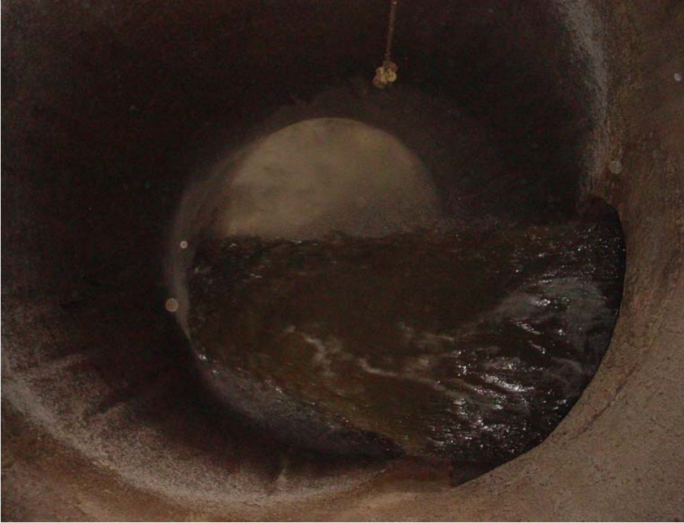
Fotos 17 y 18 Caída libre en una lum- brera y sus efectos
