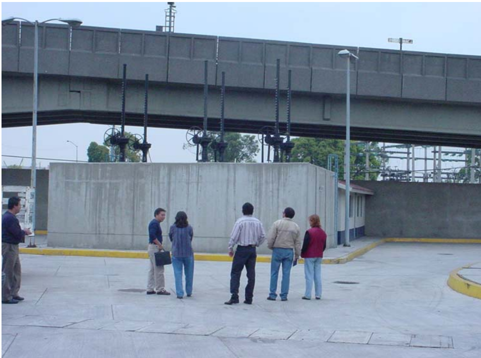
Foto 8 Visita a la planta de bombeo Zaragoza
