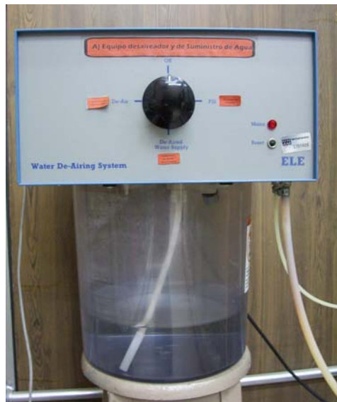
Foto 4.2 Desaireador y suministro de agua, tanque de almacenamiento.
