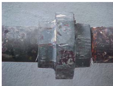
Fig. 3.34 Tuerca Unión Tipo Universal
