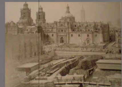
Destrucción total del Seminario.
