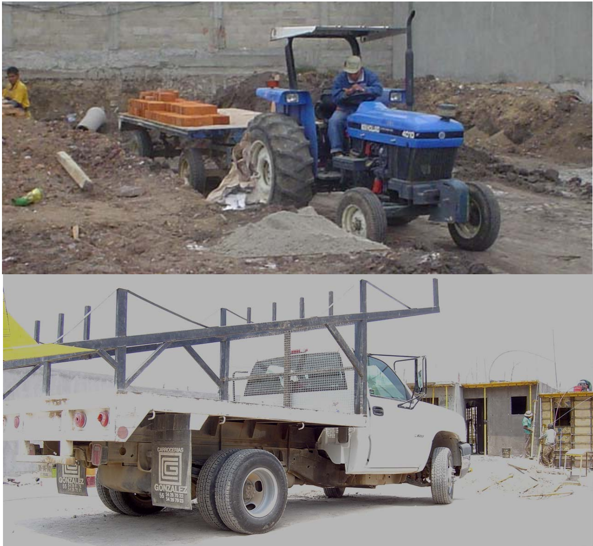
Figura 44. Distribución de tabique recocido desde el almacén local hacia los trenes de producción usando plataformas y remolques en un desarrollo. (Fuente: propia)
