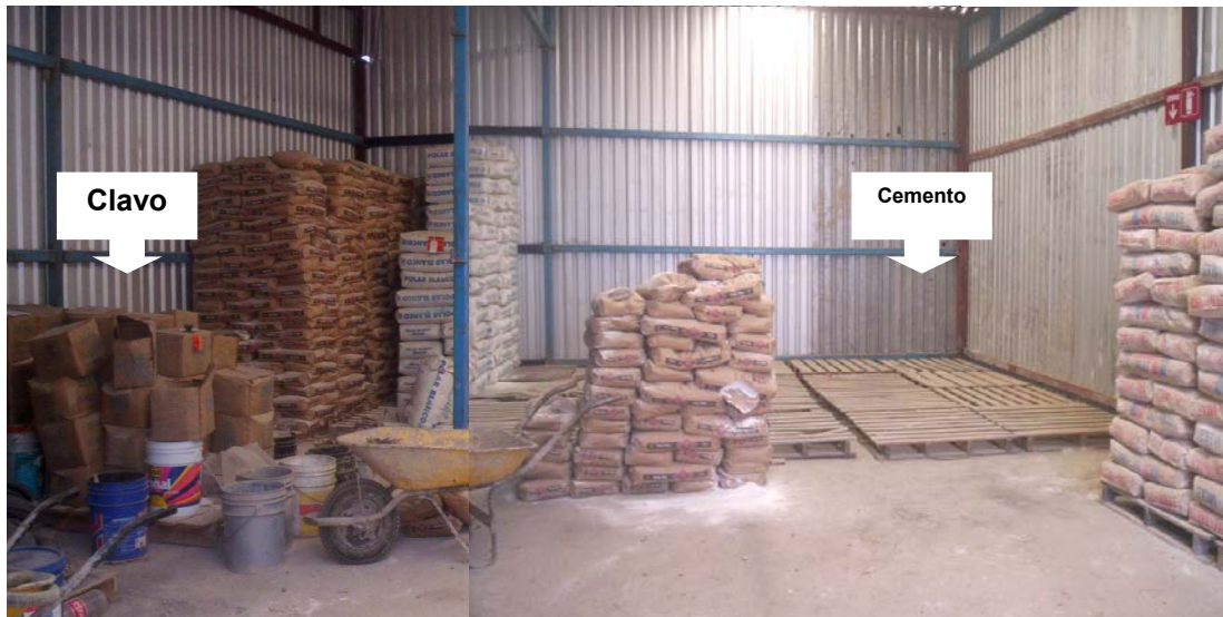
Figura 43. Ruptura de Stock de aglutinantes y simultáneamente un exceso de stock de clavo de acero en el almacén de un desarrollo en Jalisco. (Elaboración propia)
