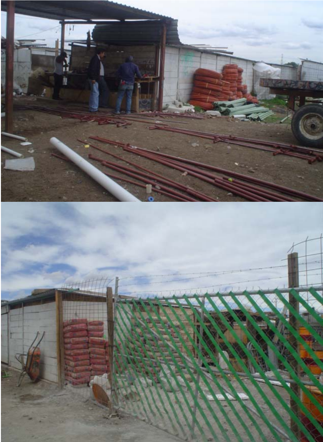
Figura 36. Bodega del material del destajista de instalaciones (arriba) y de albañilería (abajo) en un desarrollo del Estado de México.(Elaboración propia) El cemento y el mortero se encuentran libres a la intemperie, al igual que los tubos y piezas de pvc. La bodega del contratista se localiza escasamente a veinte metros del almacén de obra. En esta bodega, las condiciones de manejo, y almacenamiento ya no están controladas.
