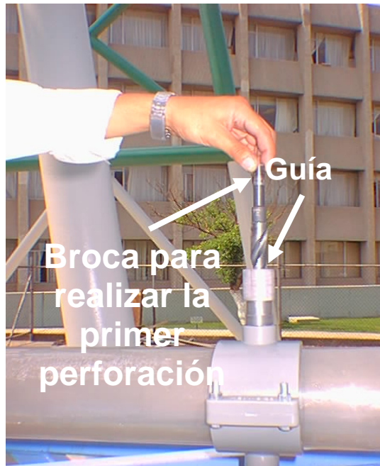
Fig. 2.16. Perforación del tubo de acrílico.
