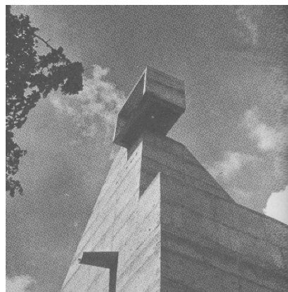
Campanario del convento de la Tourette, proyecto de Le Corbusier, Francia.
