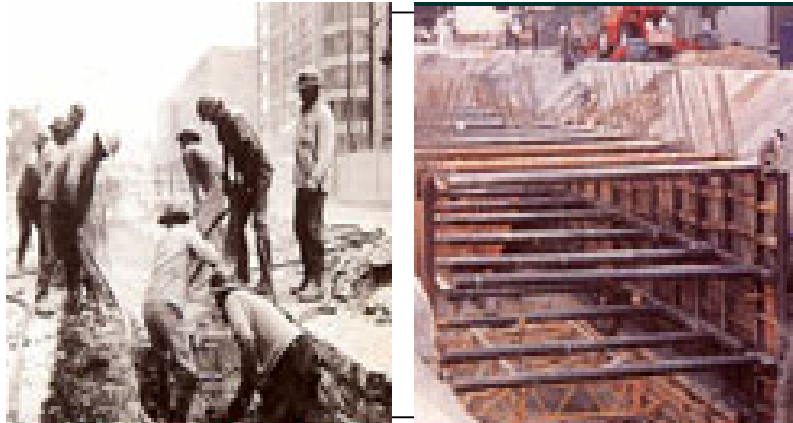
FIGURAS 1.5 A, B, CONSTRUCCIÓN DE LAS AMPLIACIONES A LA LÍNEA 2
