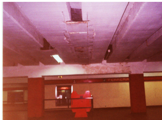
FIGURAS 4.10 A, B MUESTRAN CHAROLAS PARA CAPTACIÓN DE AGUAS PROVENIENTES DE FILTRACIONES DEBIDAS A LOS MANTOS FREÁTICOS EN LAS ESTACIONES DE LÍNEA 6
