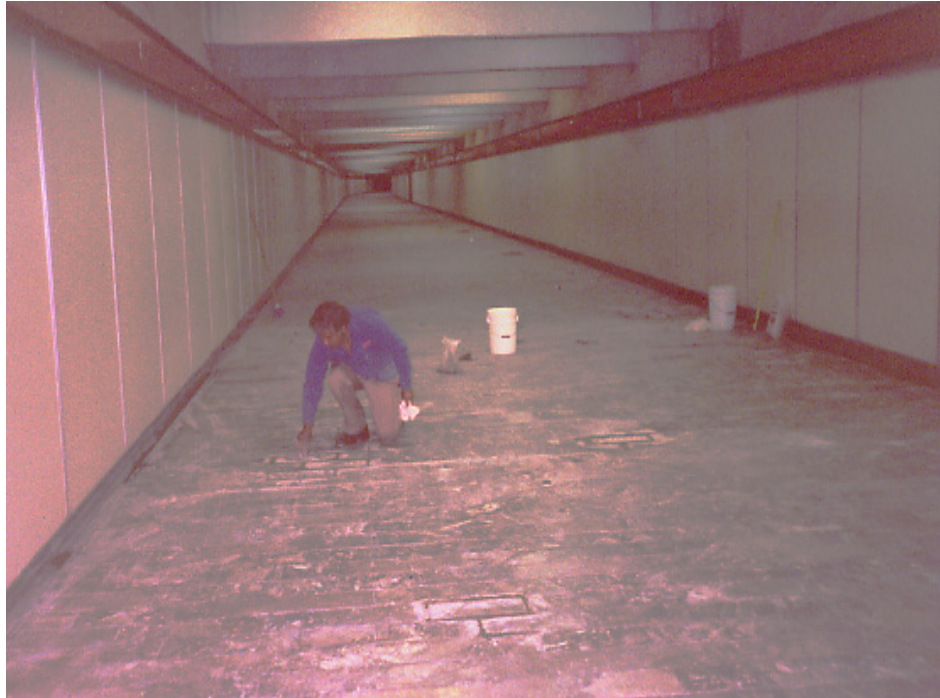
FIGURA 8.4 RECOLOCACION DEL MÁRMOL QUE SE DESPEGO POR UNA FILTRACIÓN.
