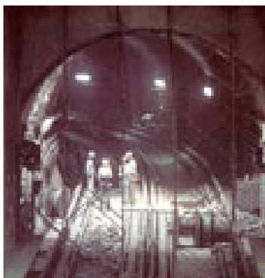
FIGURA 1.6 VISTA PARCIAL DEL TUNEL PROFUNDO EN LA CABECERA DE ANDEN II EN LA ESTACION AUDITORIO LÍNEA 7
