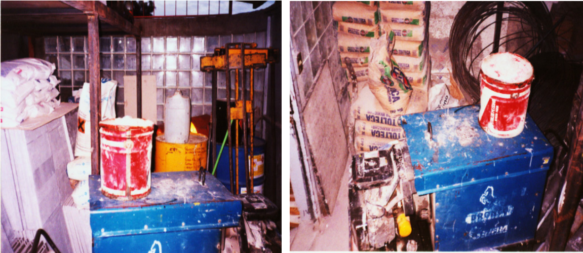
EN LA FIGURA 5.10 SE MUESTRAN DOS ANGULOS DE LA BODEGA DE MATERIALES DE ALBAÑILERÍA, DONDE SE OBSERVAN LAS MALAS CONDICIONES DE ALMACENAJE.
