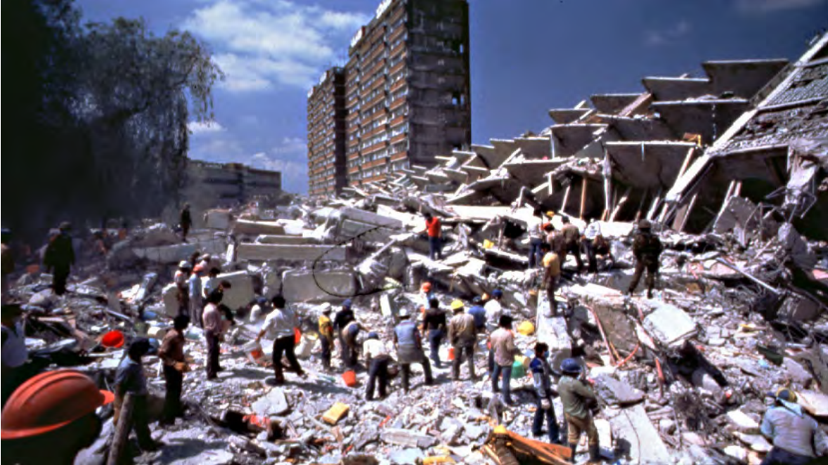
Imagen 3.1 Colapso de un edificio, después del sismo de 1985 (Ciudad de México).
