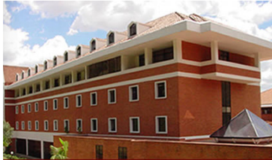
Edificio de Habitaciones
