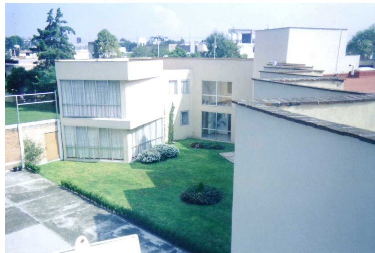
Vista exterior de la Capilla
