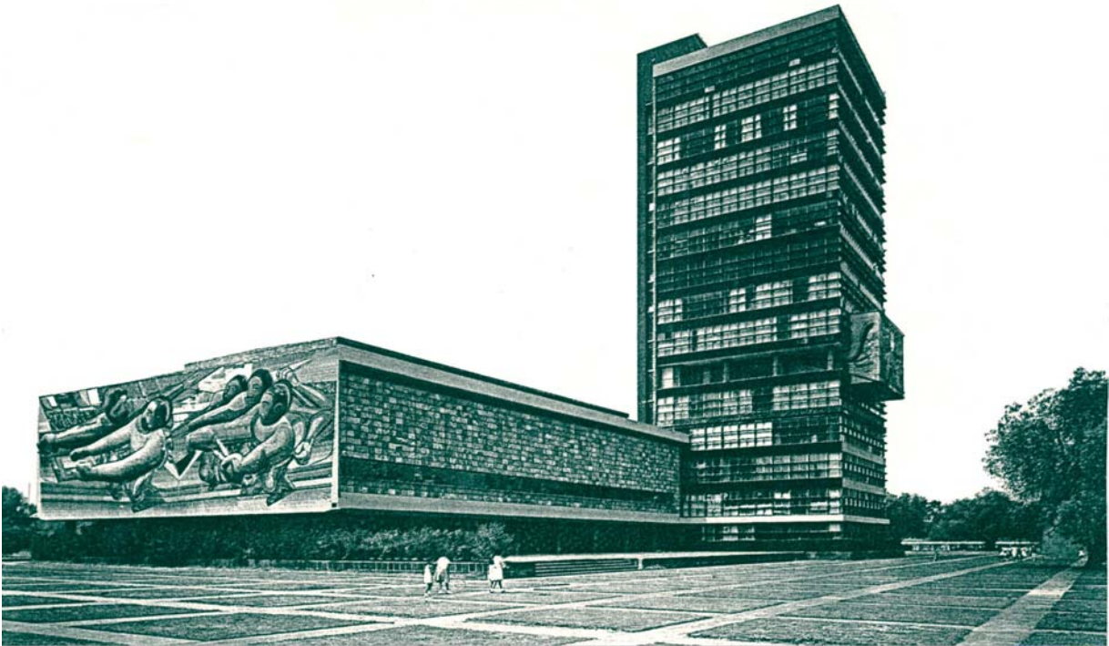
Fig. 5.3 La Torre de la Rectoría de la U.N.A.M. en la que se muestran los muros al este y al sur.
