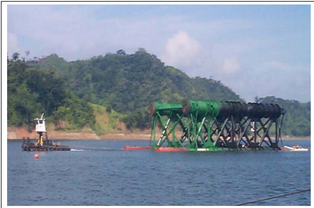
Figura 2.10 Transporte de los jackets a su posición
