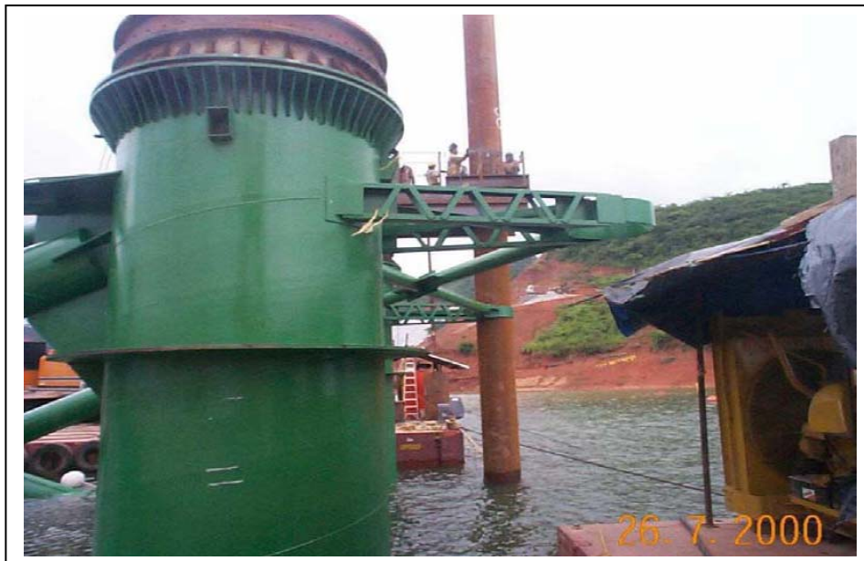
Figura 2.12 Pilotes provisionales en cada pata
