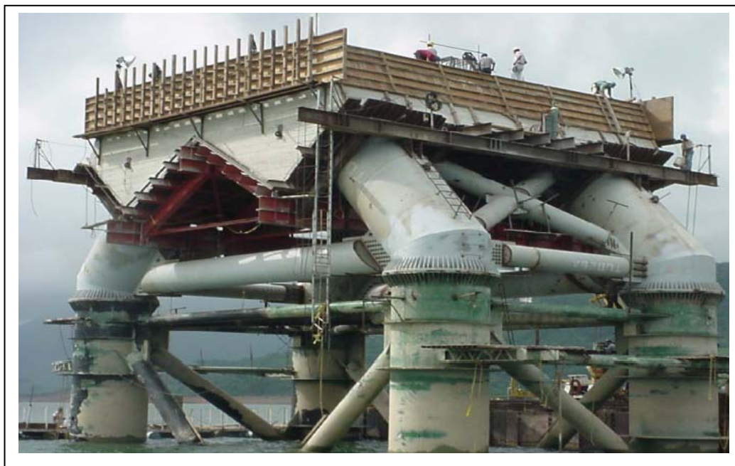
Figura 2.15 Cimbra y colado de los cabezales
