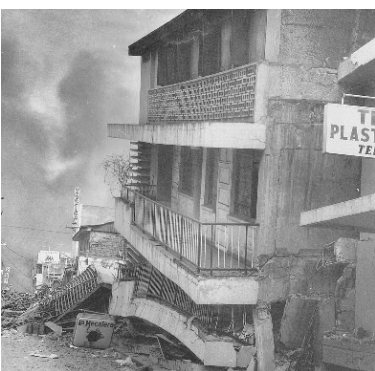
Otro edificio afectado por el terremoto de 1972
