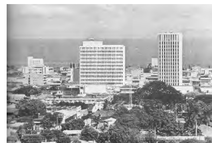
Vista del centro bancario y la Avenida central desde la casa presidencial, antes del terremoto de 1972.
