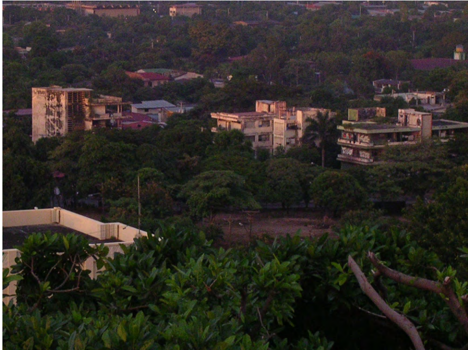
Estos edificios en ruinas, albergan familias que viven en condiciones marginales e indigentes que subsisten con la interrogante de cuanto tiempo más aguantará este techo?
