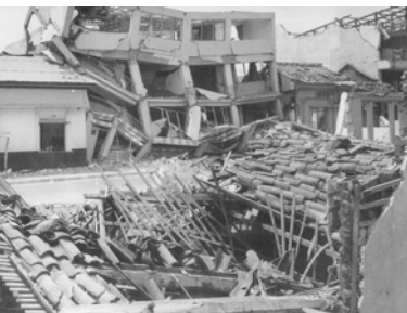
23 de diciembre de 1972. Un edificio de concreto en el centro de Managua, quedó fracturado en sus cuatro pisos.
