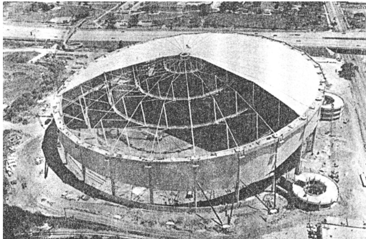
Figura 2.2 Domo Sun Coast en construcción.
