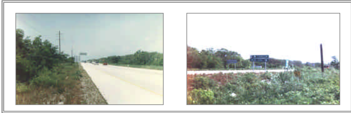
Figura: 55. Carretera federal Chetumal-Cancún Construida con Ferrocemento, es el principal acceso a las zonas turísticas en la Riviera Maya. STD 2003.
