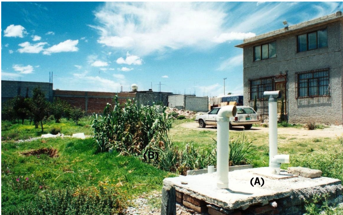
(A) Tanque de sedimentación. (B) Humedal.
