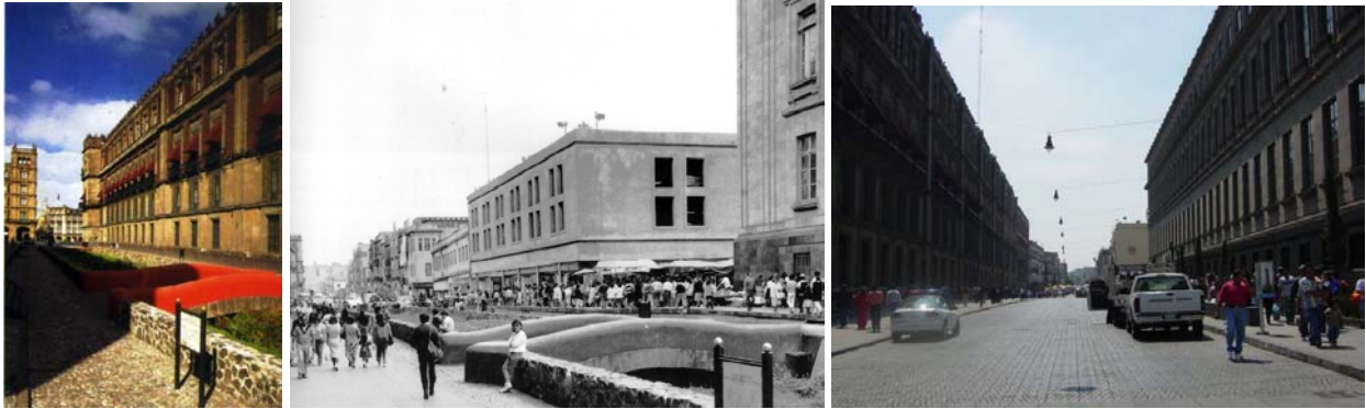
Calle Corregidora de Este-Oeste y de Oeste a Este, estado anterior y situación actual. Fachada Sur de Palacio Nacional, Acequia Real (obra conmemorativa) y nueva vialidad.
