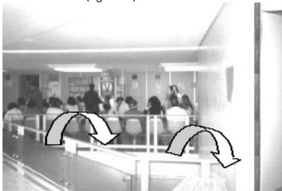
Figura 2. Vista de uno de los tres vanos en piso por donde se transmite el ruido entre la planta alta y la planta baja.
