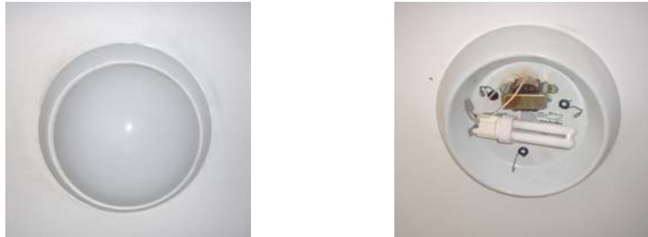
Figura 4.5 LFC en un Luminaria Cerrado Fuente: Philips-Construlita
