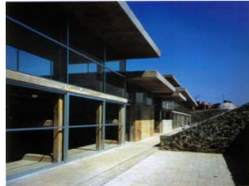
Vista Norte del Conjunto
