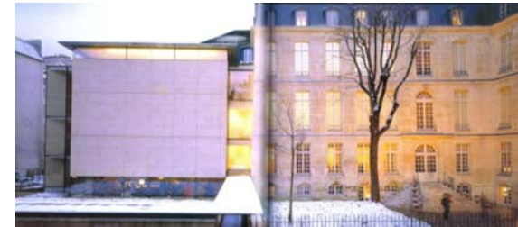
Vista de los dos edificios
