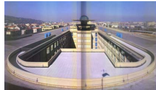
Azotea del edificio original (rampas de descenso)
