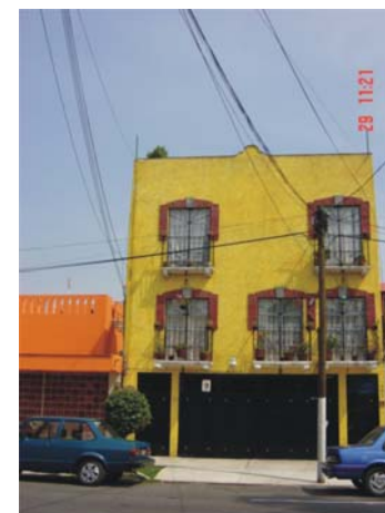
Cableado en Fachada Norte
