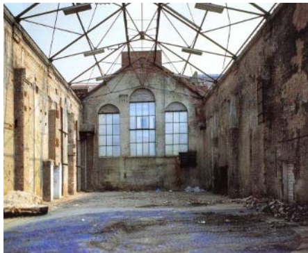
Vista antes de su intervención
