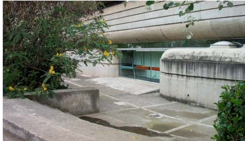
Acceso al foro por la fachada oeste.
