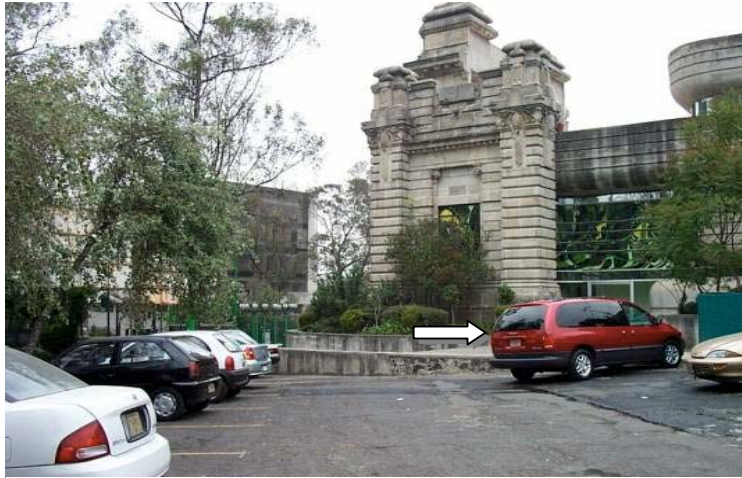
El acceso a la galería por la fachada este que comunica con el estacionamiento.
