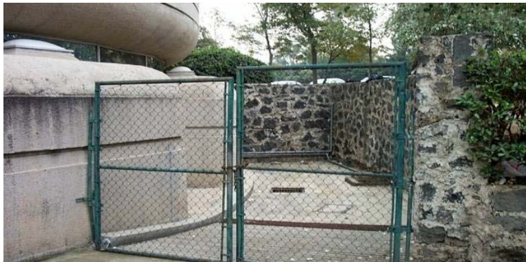
Acceso al área de carga y descarga.
