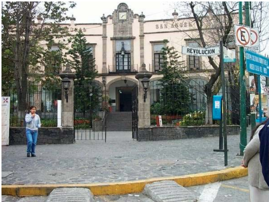
Fachada y Plaza de acceso principal, rampa para minusvalidos.
