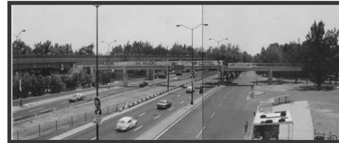
Viaducto Río de la Piedad. (Foto 1)
