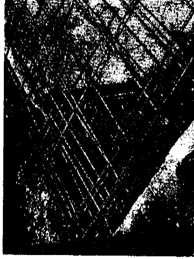
Foto 21. Detalle del armado acero en dado, donde se ubicará posteriormente las anclas.
