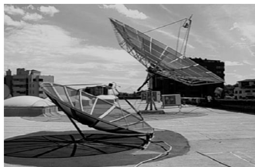
Antena de enlace unidireccional de microonda abajo y Antena receptora de Edusat arriba , UPN-Ajusco (2004)
