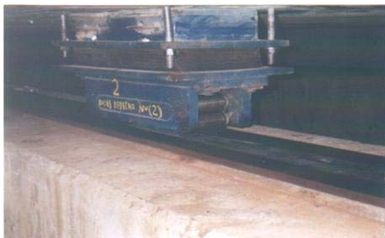
Apoyo móvil deslizante, utilizado en los cabezales de pilas.
