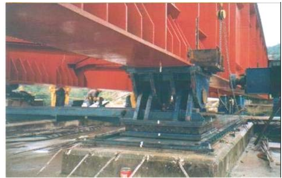
Apoyo móvil deslizante, utilizado en los cabezales de pilas.
