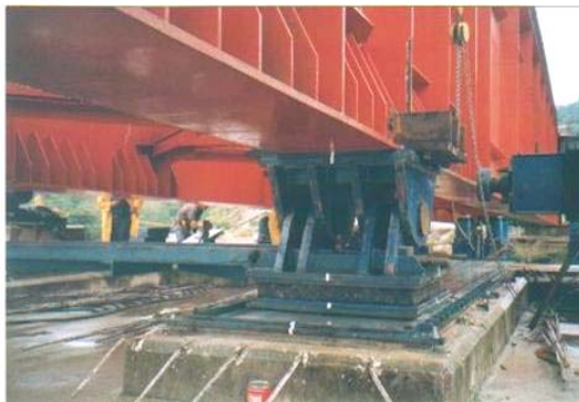
Apoyo móvil deslizante, utilizado en los cabezales de pilas.
