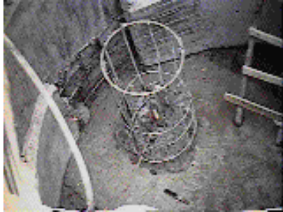
Cabezal de un pilote colado in-situ
